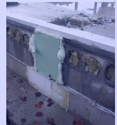
Naden isolatie afdichten voor optimaal resultaat
