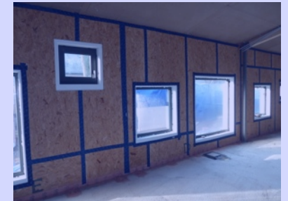
Langs- en stuiknaden OSB-platen aftapen
