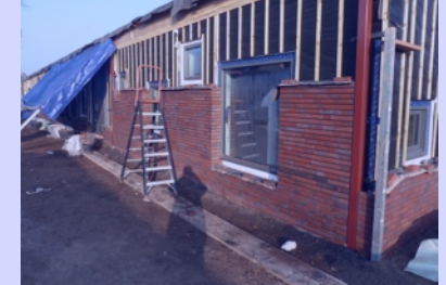
houten geïsoleerde kozijnen met driedubbel glas
